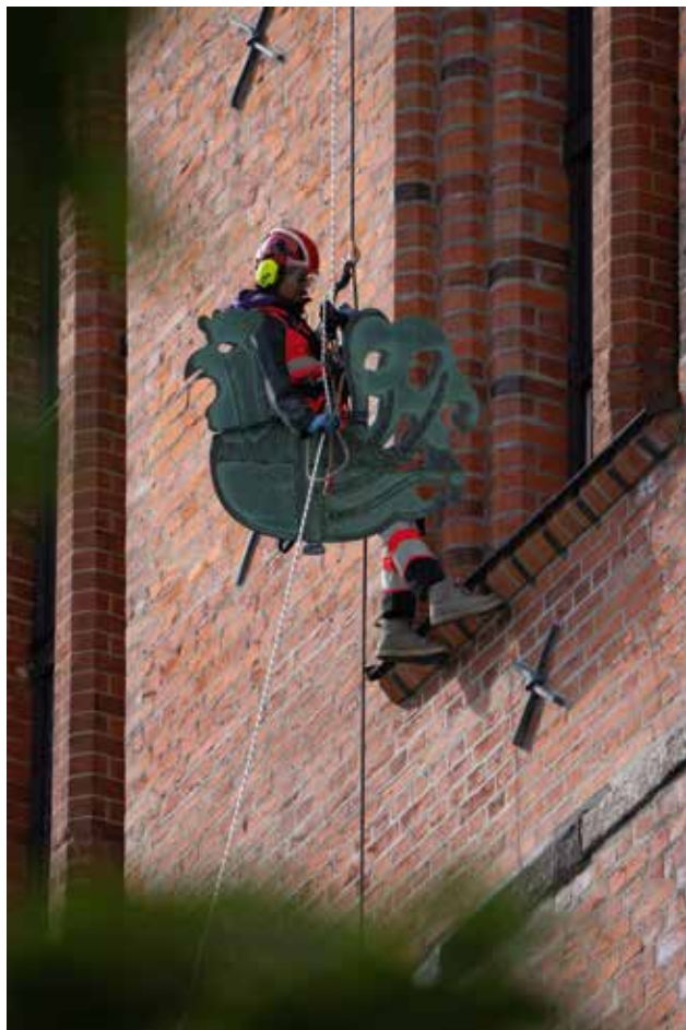
Der Wetterhahn wird abgeseilt
