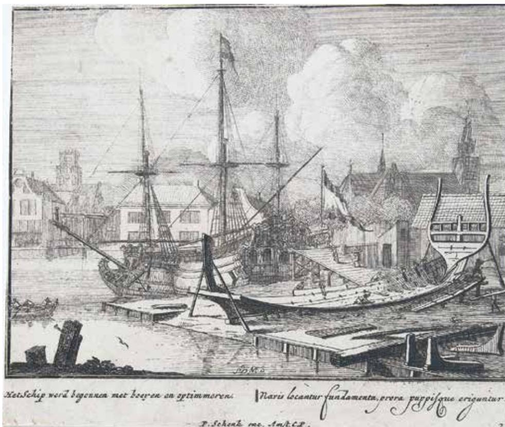
De opbouw van het schip, plaat nr. 2, ca. 1700, Siewwert van der Meulen, 1690–1710. Das Bild zeigt ein auf Kiel gelegtes Schiff, dessen Rumpf im freien Bau, d. h. ohne Spanten, hochgezogen wird.
