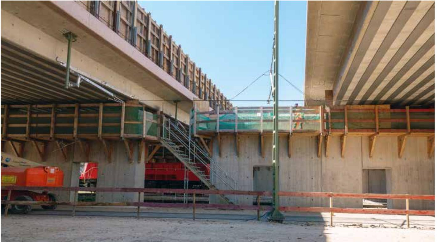
Vor der Brückenverschiebung, Blick von unten, links der östliche Brückenkörper: Der Oberleitungsmast in der Bildmitte musste noch in der Nacht von Freitag auf Sonnabend mittels Kran entfernt werden (Foto: Burkhard Zarnack)
