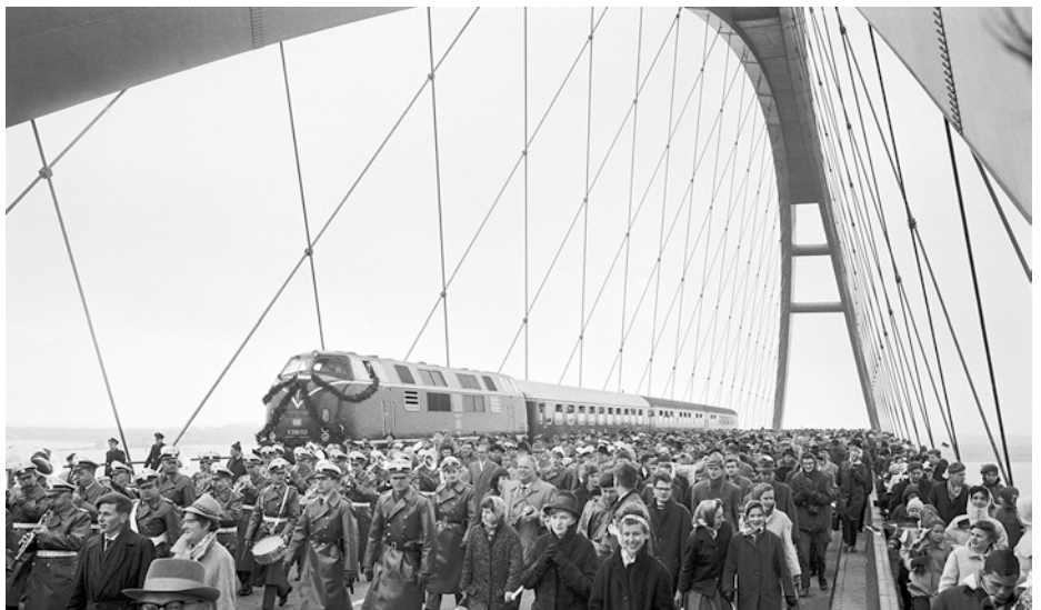
Großenbrode, drei Jahre hat der Bau der Fehmarnsundbrücke gedauert. Am 30. April 1963 wird die Brücke von Verkehrsminister Seebohm dem Verkehr übergeben (Foto: Lübecker Nachrichten/Hans Kripigans)
