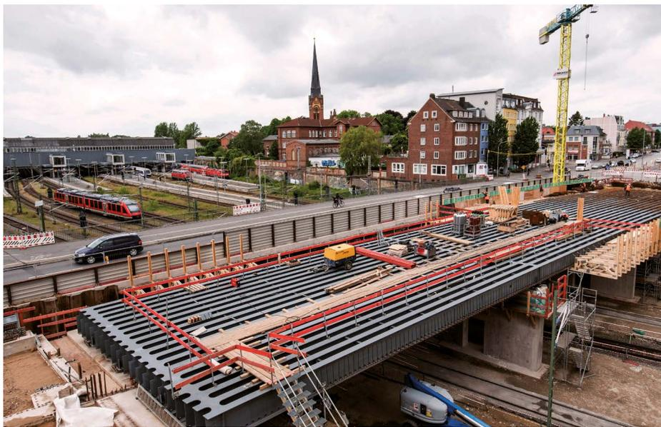
Die Bahnstiftsbrücke im derzeitigen Bauzustand (Ende Mai 2022): Die neuen Stahlträger auf der Nordostseite sind eingebracht. Der Verkehr verläuft derzeit zweiseitig über den alten Brückenkörper auf der Südwestseite (Foto: Burkhard Zarnack).
