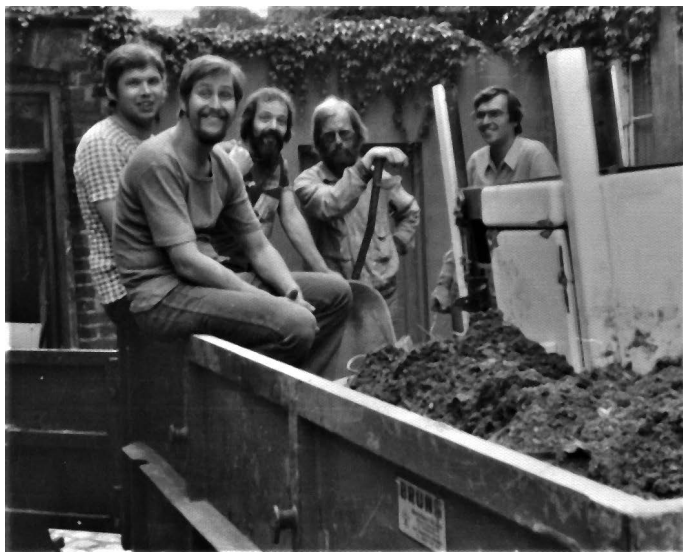
Saniererhilfe 1976: Container-Füllen in der Wakenitzmauer (Foto: Privat)
