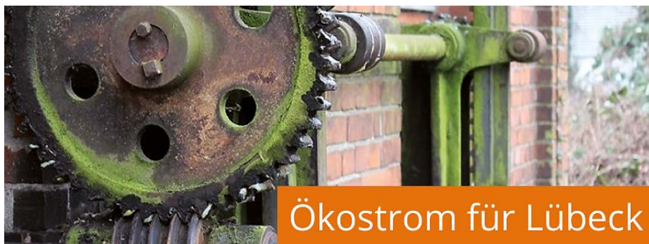
Die Wasserkraftanlage am Mühlendamm (Detail)
