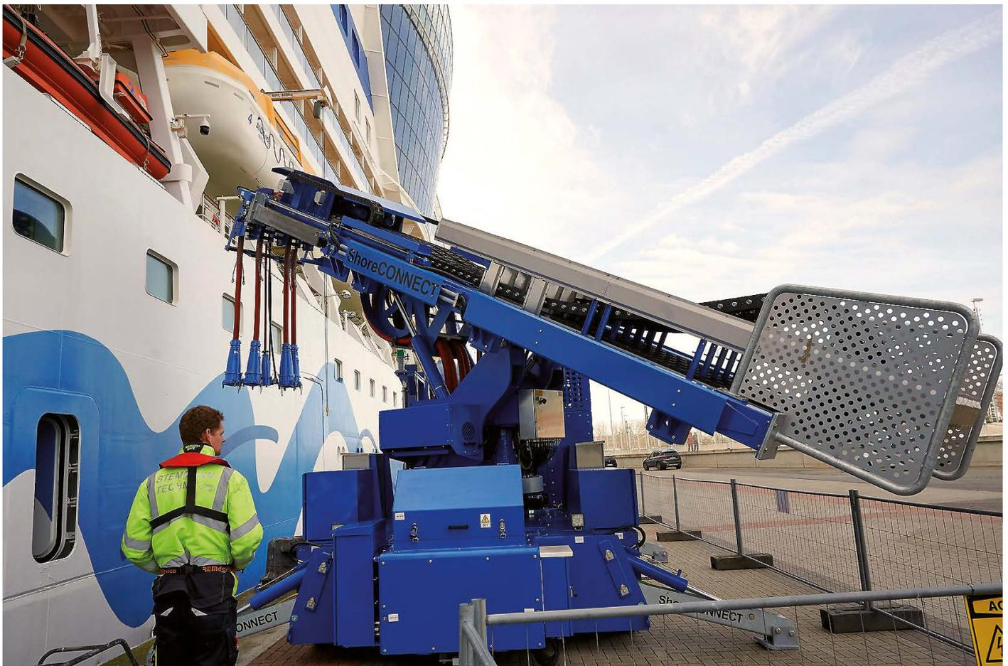
Landstromanlage am Kreuzfahrer-Terminal Rostock, die 2020 fertiggestellte Anlage ist aktuell die größte Europas und kann bis zu 20 Megavoltampere elektrische Energie liefern. (Foto: Port of Rostock)
