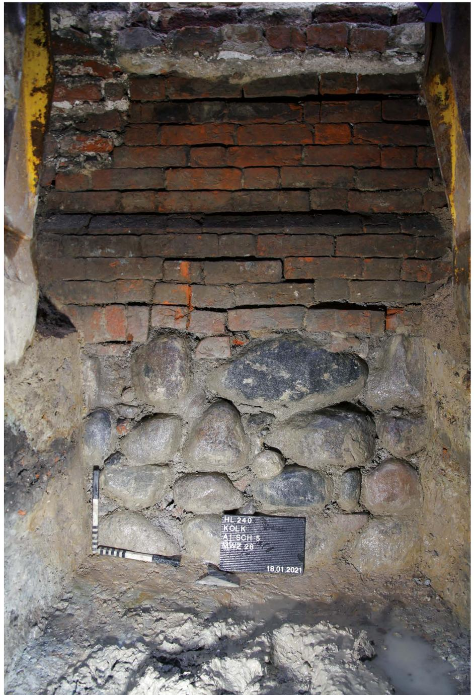
Abb. 2: Findlingsfundamentierung mit Backsteinmauerwerk und Zierstreifen im Vordergiebel von Kolk 14
