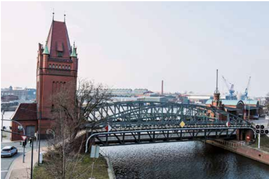
Das denkmalgeschützte Hubbrückenensemble besteht aus drei Brücken: In der Mitte die Brücke für den Autoverkehr, davor der Fußgängerüberweg mit den beiderseitigen Treppen und auf der Hafenseite – im Bild hinten – die (ehemalige) Eisenbahnbrücke.
