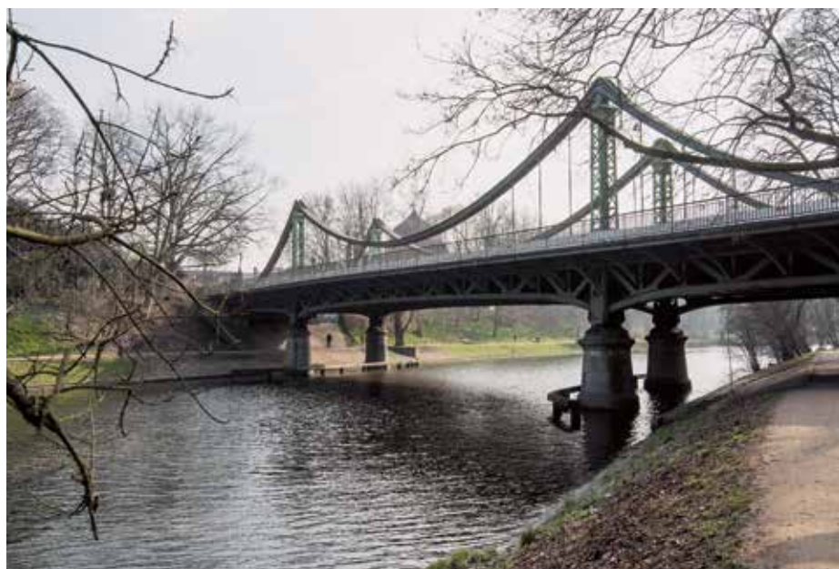
Auf dieser Seite der Mühlenbrücke wird die Fußgänger- und Fahrrad-Behelfsbrücke montiert: links Mühlentorteller, rechts Altstadt. (Fotos: B. Z.)
