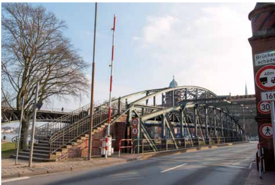
Auf diesem Bild ist eine der Treppen für den jetzigen Fußgänger-Überweg zu erkennen.
