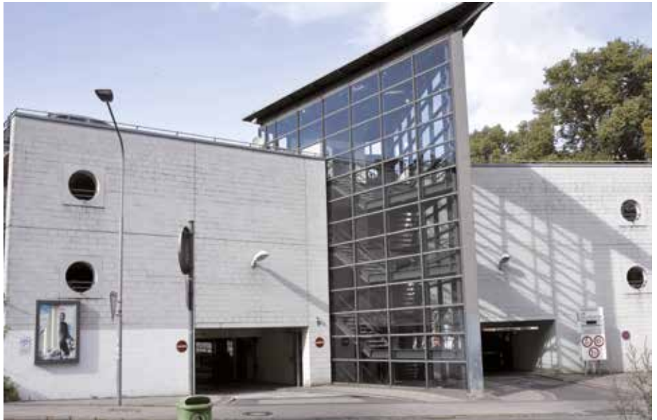
Das baufällig gewordene Holstentorparkhaus wird in den nächsten drei Jahren abgerissen und durch einen Neubau ersetzt. Ein weiterer Neubau soll auf der Mittleren Wallhalbinsel entstehen.
