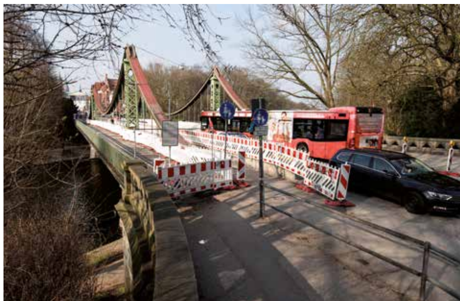
Die momentane Verkehrssituation auf der Mühlenbrücke: noch können Fußgänger und Radfahrer passieren.
