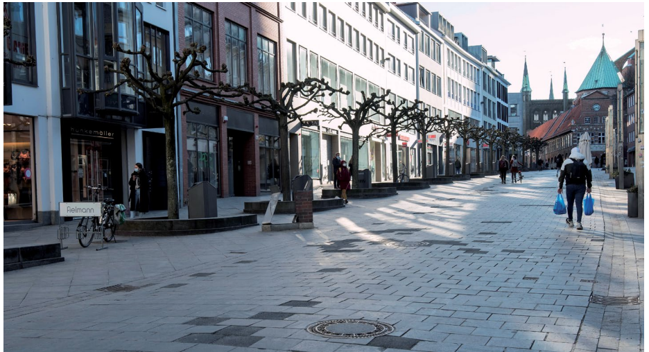
Die Breite Straße im unteren Ende. Sie soll verschönert und ausgebessert werden. Das Pflaster hat – wie man sieht – ziemlich gelitten (Ursache u. a. schwerer Zulieferverkehr) (Foto: BZ)
