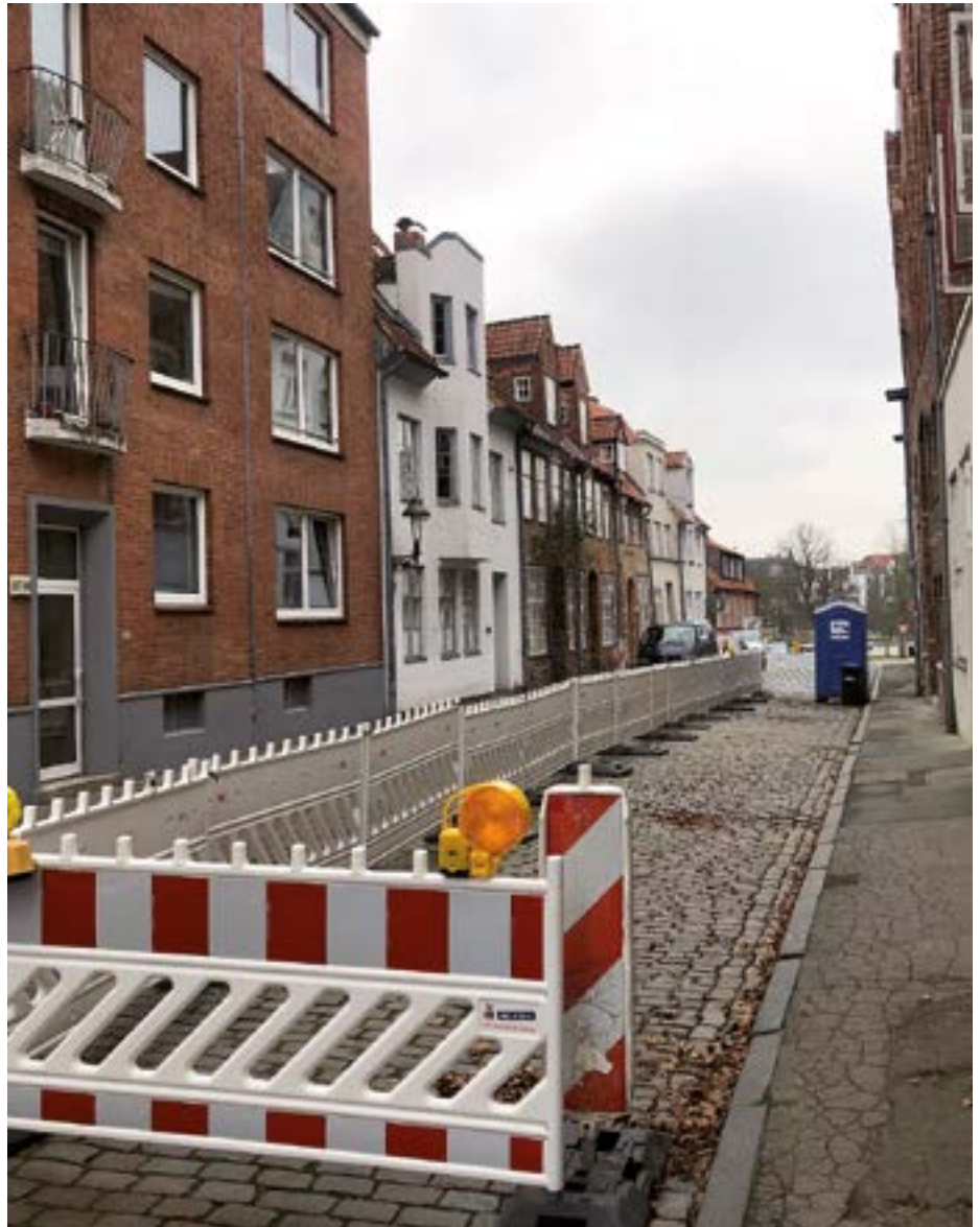
Abb. 3: An dieser Baustelle werden etwa sechs Stellplätze blockiert – auch nachts und an Wochenenden, wenn hier gar keine Bauarbeiten stattfinden. (Foto: Bodo Fabian)
