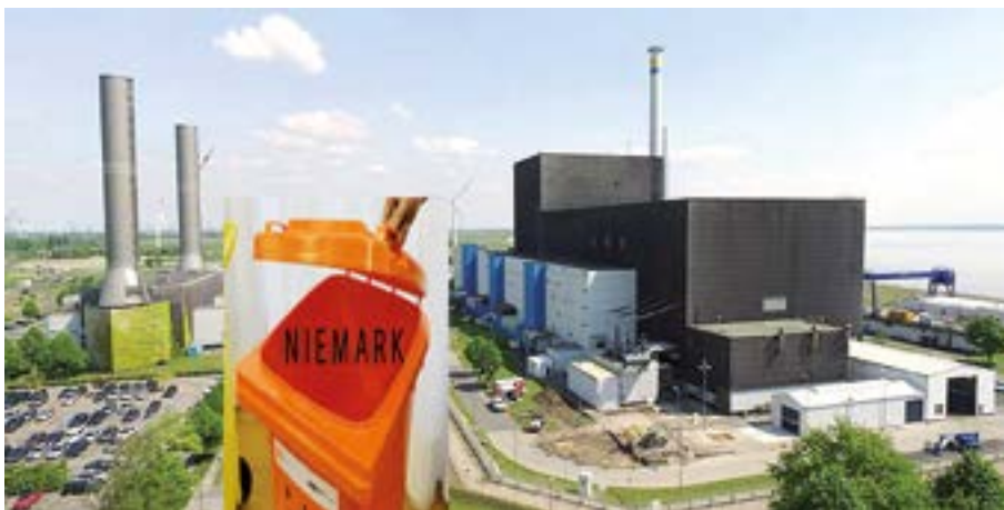
KKW Brunsbüttel, Kraftwerksblock
