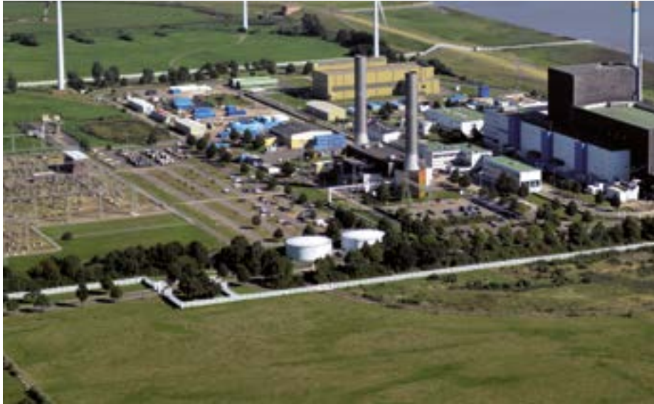
Kernkraftwerk Brunsbüttel, Gesamtanlage. Die Kraftwerksbetreiber vermitteln Informationen über die Angaben der Abrissmengen. Die zuerst genannten kleineren Mengen beziehen sich nur auf das Jahr 2021 (!) (= 240 oder 400 t), die Folgeangaben dagegen auf die nächsten Jahre (= 12.500; 18.000 t ?) (Foto:© Vattenfall)
