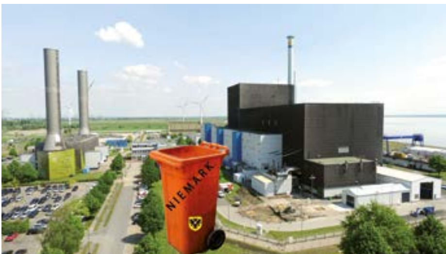
KKW Brunsbüttel, Kraftwerksblock
