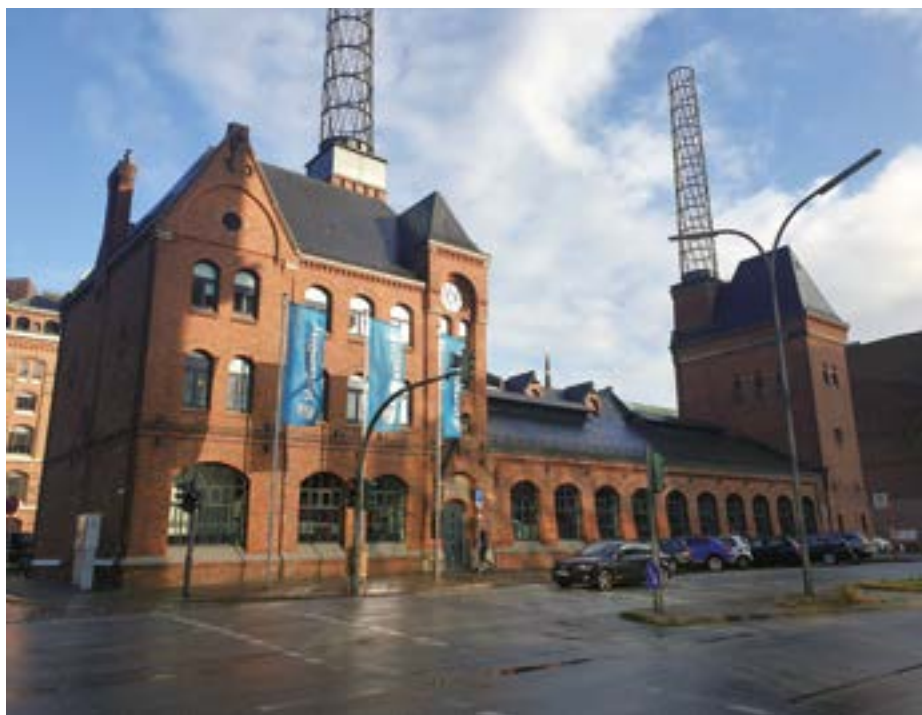
Die Maschinenzentralstation in der ehemaligen Hamburger Speicherstadt
