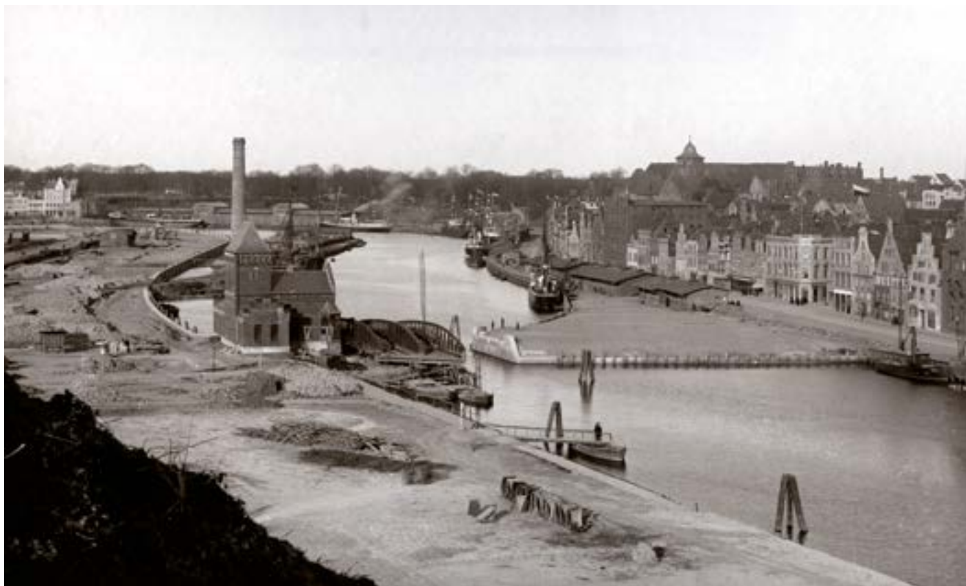
Großbaustelle Untertrave, etwa 1892, in der Bildmitte die entstehende Drehbrücke
