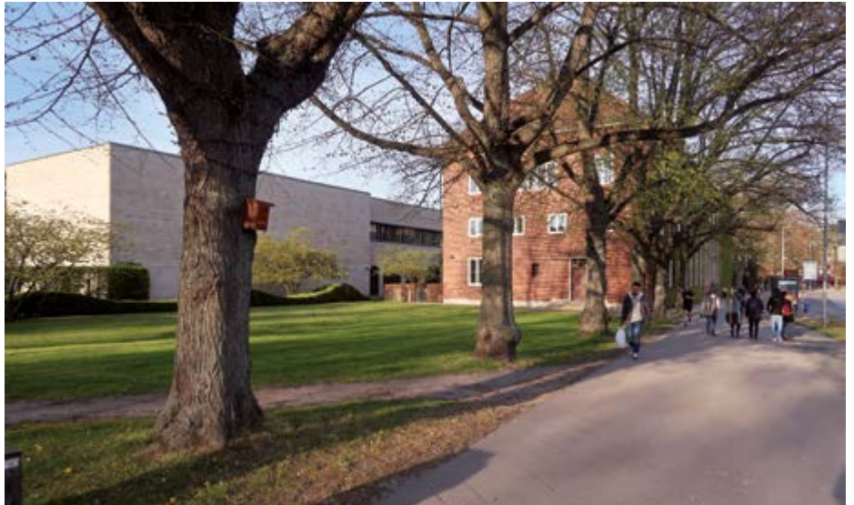
Die Gebäude der Bundesbank am Holstentorplatz. Wird unser Bürgermeister je wieder Geld haben, um über Ankauf und Umnutzung nachzudenken? (Foto: ME)
