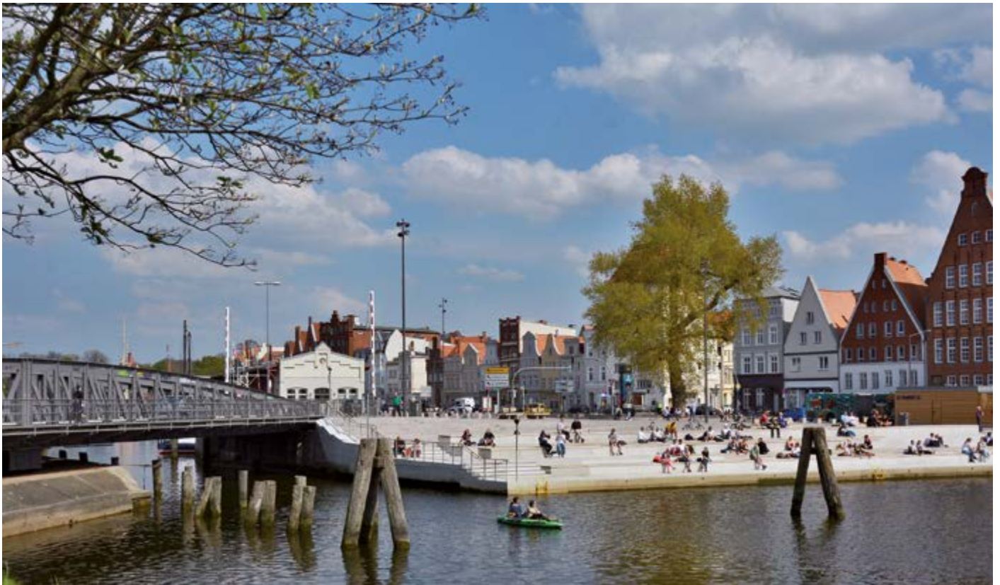
Der neue Platz an der Drehbrücke, kaum fertiggestellt, schon dankbar angenommen; hier in einer Aufnahme vom 27. April, nachmittags gegen 15 Uhr. (Foto: Ekkehard Retelsdorf, PGL)
