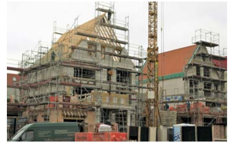
Rückfassaden in der Braunstraße
