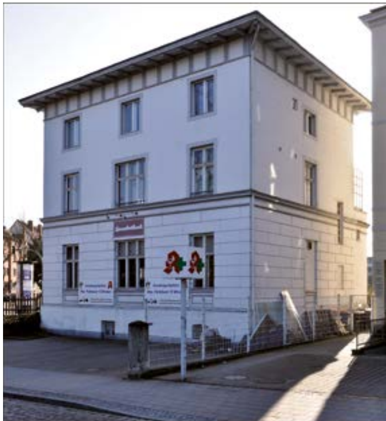
Die älteste Villa in St. Lorenz-Nord am ZOB wurde am 30.04. abgerissen.
