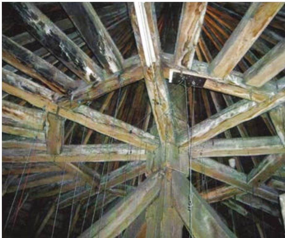
Die Arbeitsgruppe um Frau Dr. Templin hat 2016 vorgeschlagen, zukünftigen Besuchern des Holstentors einen Blick in das Innenleben eines der Türme zu ermöglichen. (Foto: Denkmalpflege HL)
