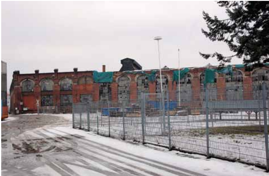
Ehemalige Schiffbauhalle der LMG, Einsiedelstr. 6, 1907/08 errichtet, in Betrieb bis 1987, Leerstand, Verfall
