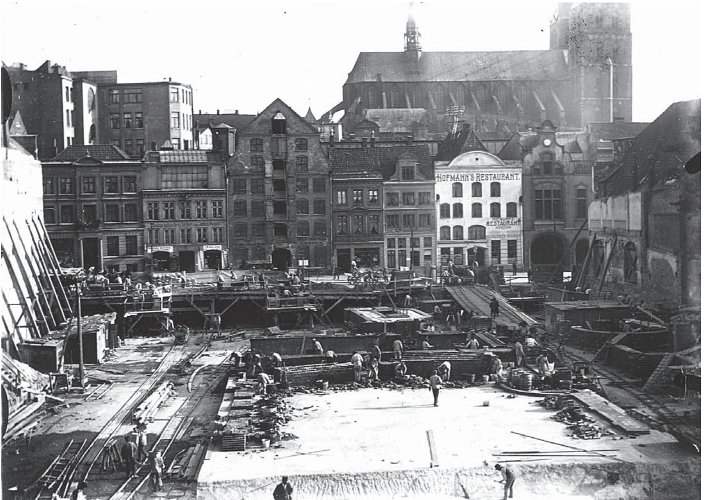
Großbaustelle zwischen Fischer- und Beckergrube: Der von Emil Possehl gestiftete Theaterbau wächst seit 1907 aus der Erde.
