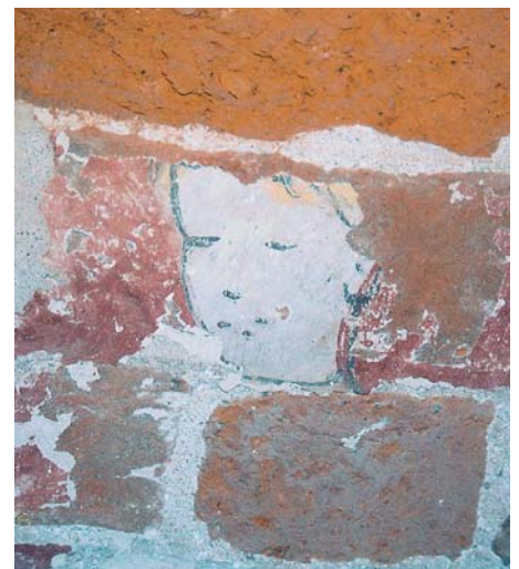
Reste eines Kopfes auf der Wand in der Langen Halle
