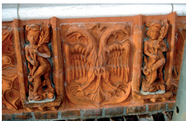
Restaurierte Terrakotten-Platten: Wilder Mann und Wappenadler
