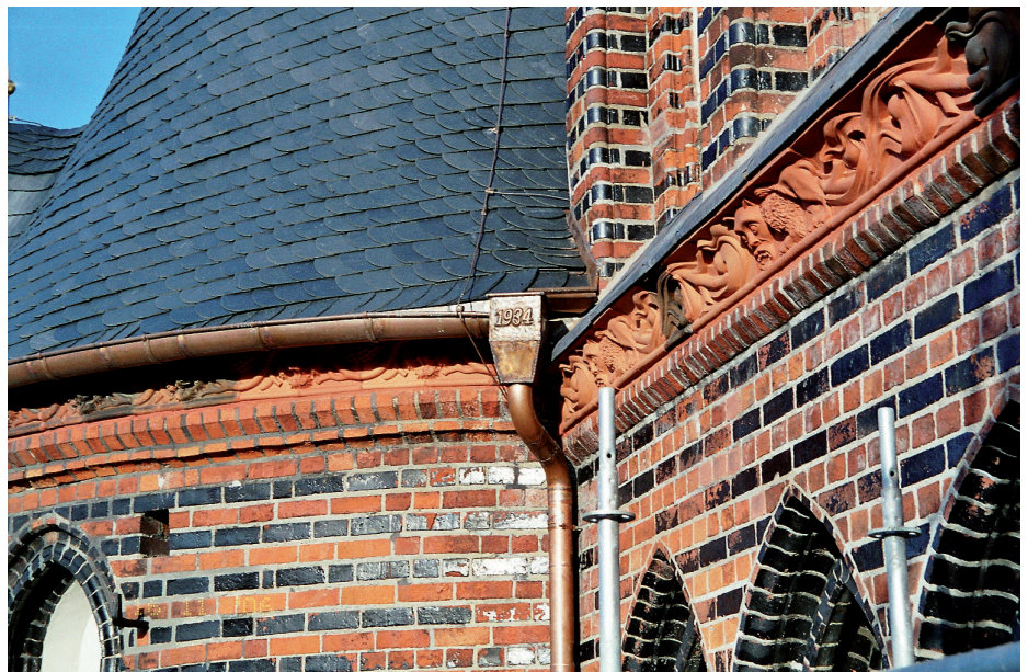
Fertig instandgesetzter Dachgesimsfries
