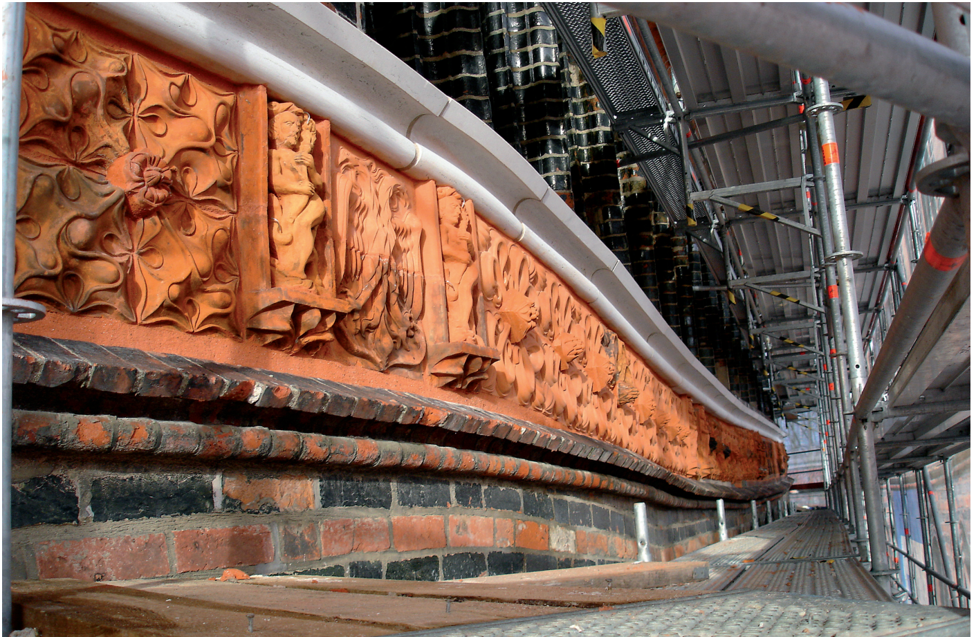
Restaurierter und erneuerter Zustand: Terrakottafris mit Kalksteingesims
